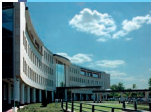
Budynek Centrali ZUS. Zbiory ZUS
