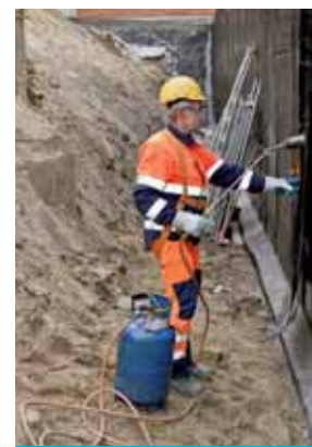
Bezpieczne zejście do wykopu.
