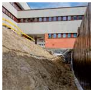
Bezpieczne nachylenie skarp wykopu.
