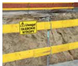
Zabezpieczenie krawędzi wykopu.
